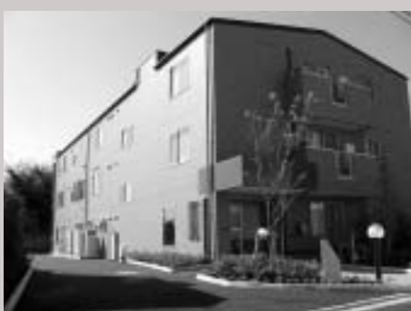
三光ソフランが建設したグループホーム西荻北
