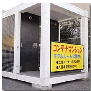
コンテナマンションの「アズキュービック」
