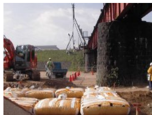
工事現場の地盤改良に利用されている「D・BOX」
